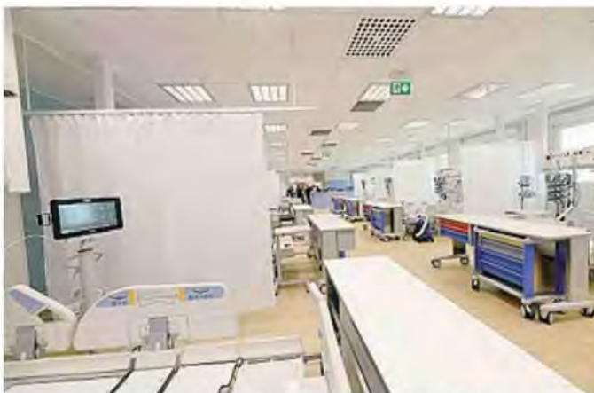
La terapia intensiva del nuovo Emergency Hospital a Rozzano
